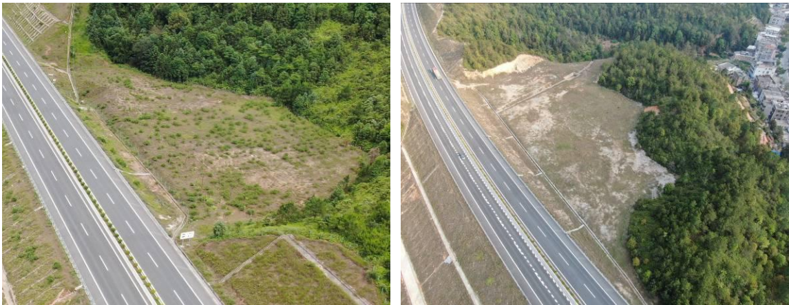
沿线填平区现状
