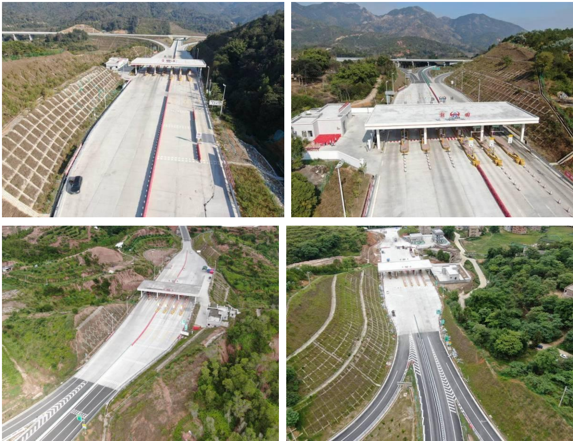
沿线收费站现状
