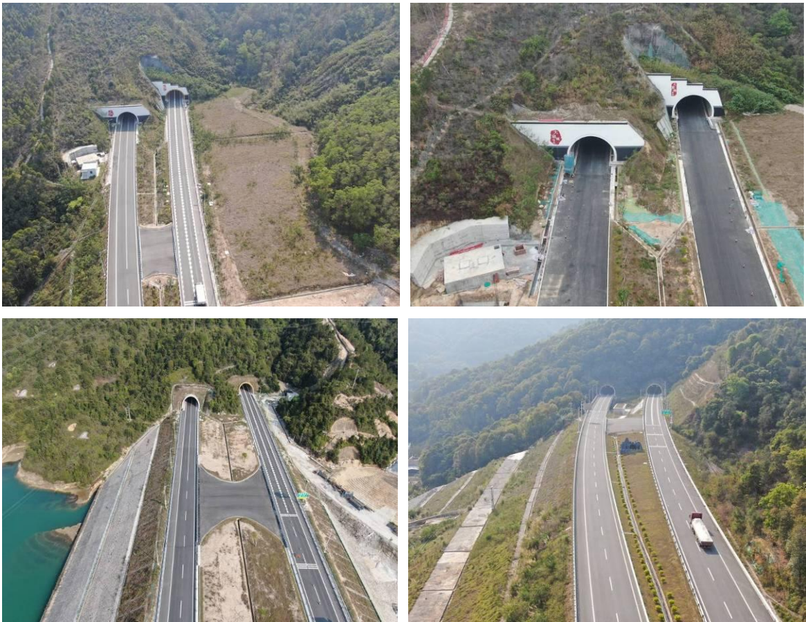
隧道工程现状
