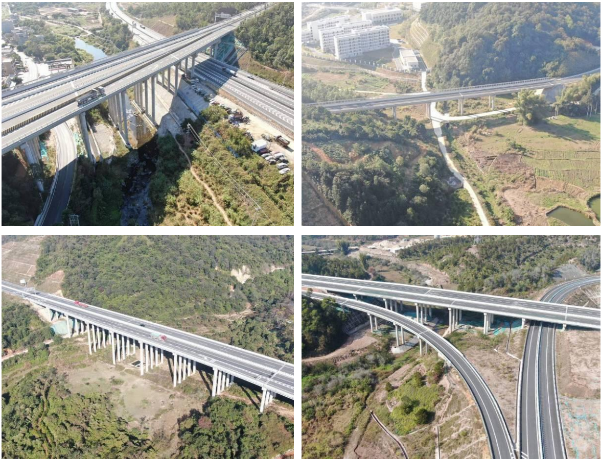
桥涵工程现状
