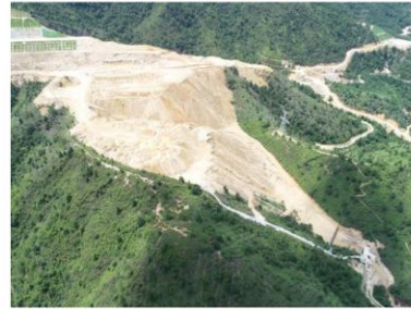
TJ2 标弃土场挡渣墙溢流严重
