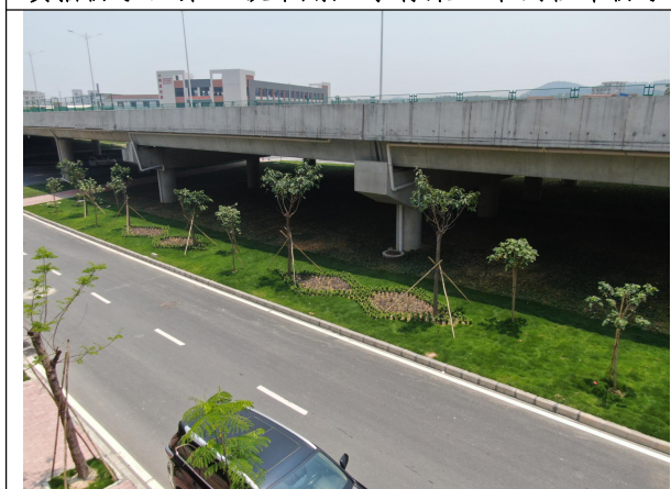
广蟠线跨线桥桥底绿化
