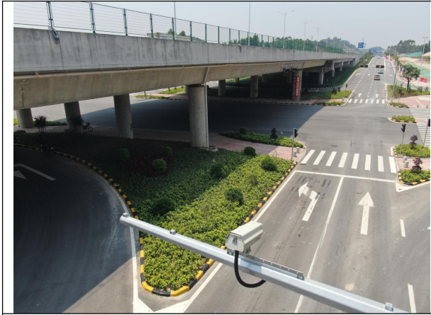
燕五线跨线桥桥底完成绿化恢复措施
