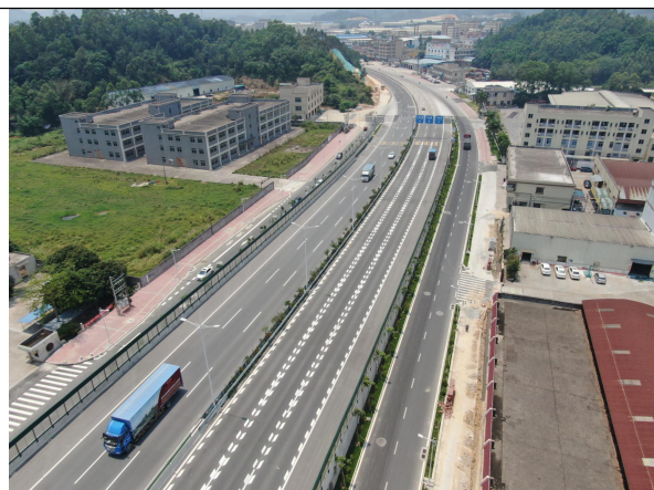
国道 G325 高架桥
