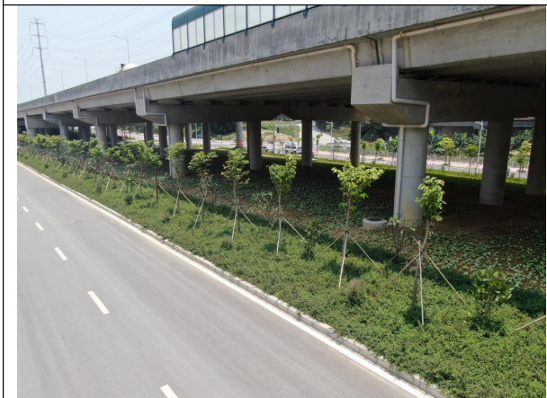
碧桂大道跨线桥桥底完成绿化恢复
