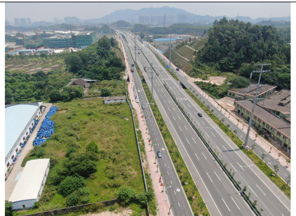
K47+649 完成中央绿化带、侧分隔带绿化
