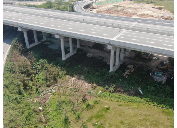
大雁山互通主线桥底部分区域已实施植被恢复
