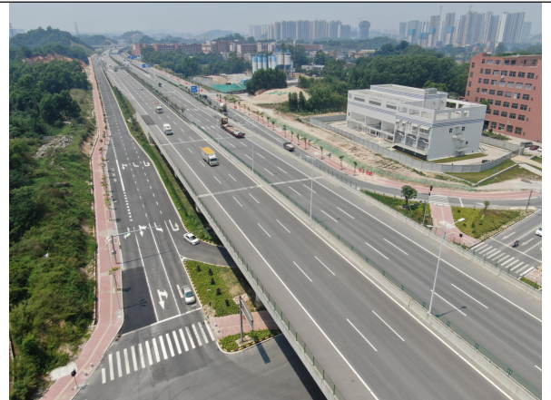
K43+699 段桥底完成绿化恢复措施
