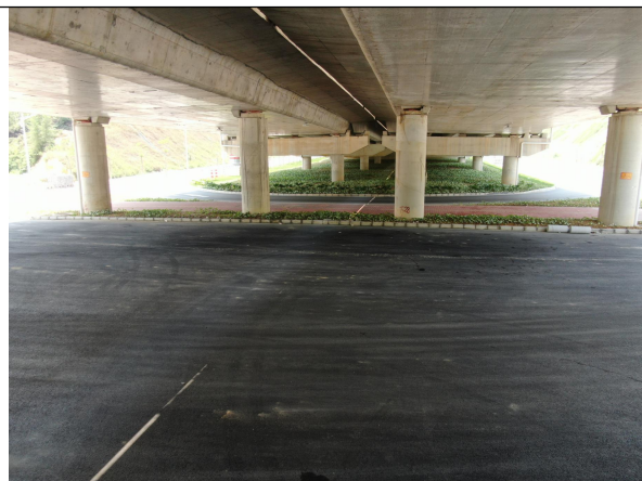
前进南跨线桥桥底绿化
