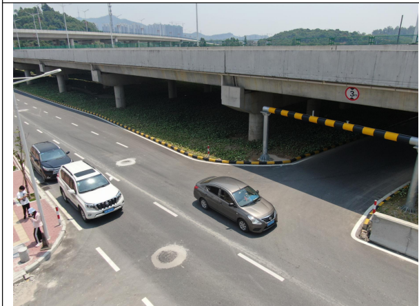
上社立交桥底完成绿化恢复
