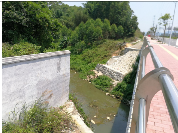
蚬江河中桥桥台实施 C20 砼六棱块防护
