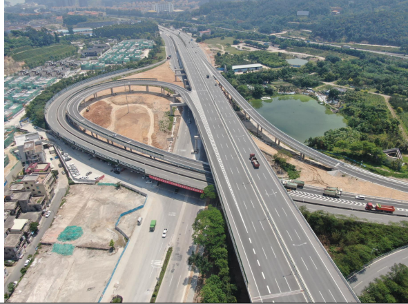
大雁山互通绿化区完成平整未绿化
