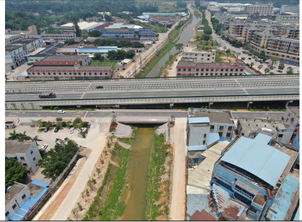
桃源中桥桥台实施 C20 砼六棱块防护
