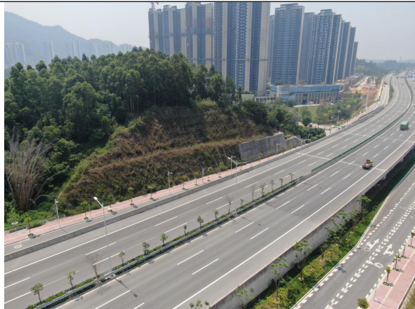
K41+900 段采用锚杆加固+三维网植草防护
