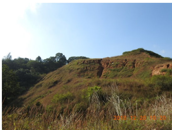
K49+500 左侧临时堆场
