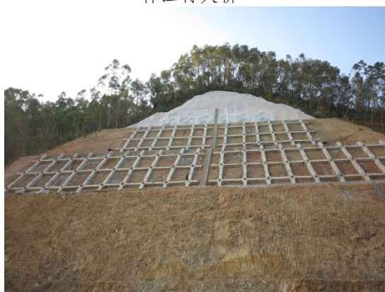
K23+300 左侧挖方边坡
