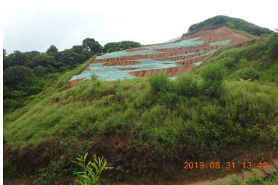
K49+500 左侧临时堆场
