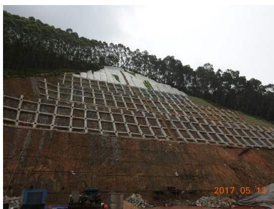
K23+300 左侧挖方边坡
