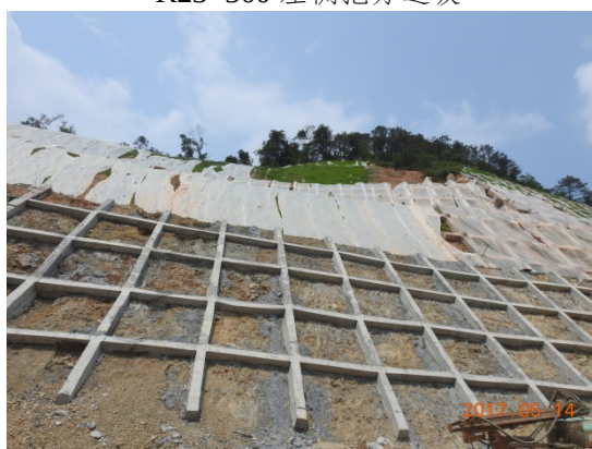
K46+800~K47+900 右侧挖方边坡
