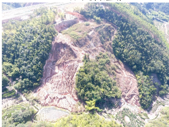
K3+480 右侧弃渣场
