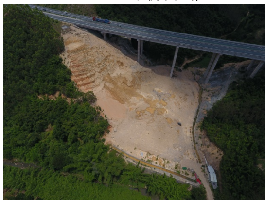
K4+200 右侧河西大桥底弃渣场
