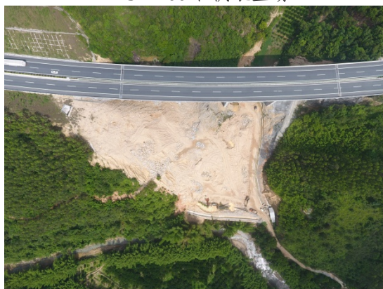
K4+200 右侧河西大桥底弃渣场
