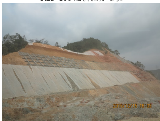
K46+800~K47+900 右侧挖方边坡
