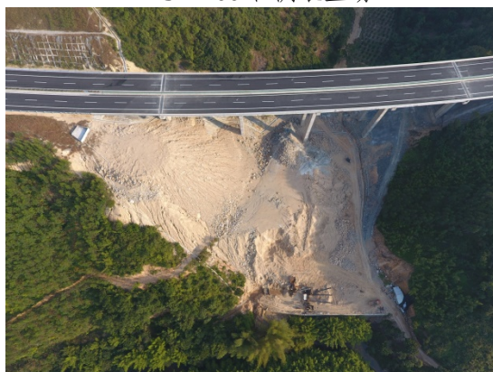
K4+200 右侧河西大桥底弃渣场
