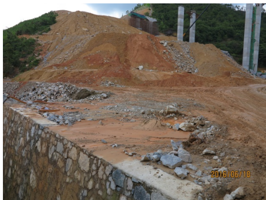
K4+200 右侧河西大桥底弃渣场
