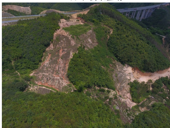
K3+480 右侧弃渣场
