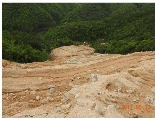
K3+480 右侧弃渣场
