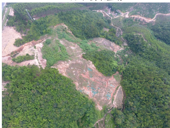
K3+480 右侧弃渣场
