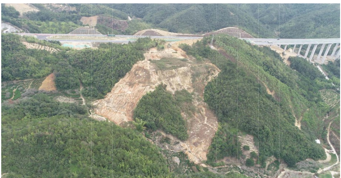
图4.2-2 K4+200线路右侧河西弃渣场现场查勘图
