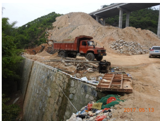
K4+200 右侧河西大桥底弃渣场
