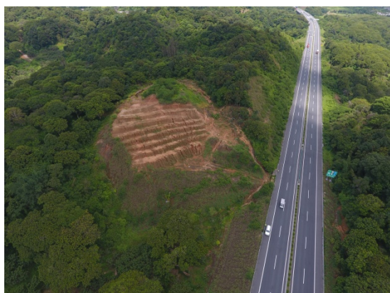
K49+500 左侧临时堆场
