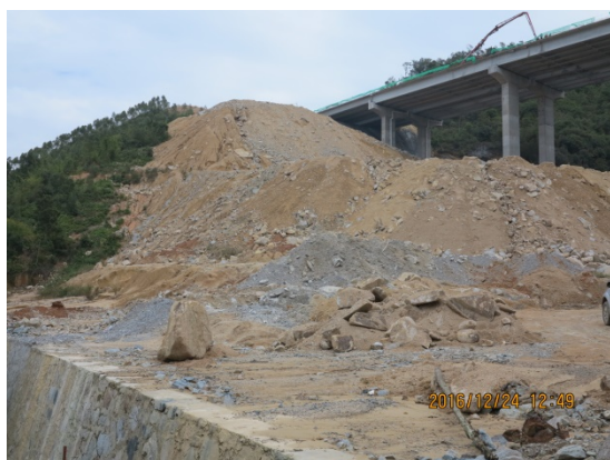
K4+200 右侧河西大桥底弃渣场
