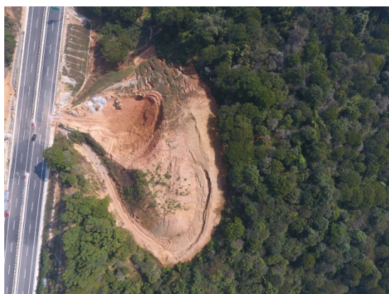
K49+500 左侧临时堆场
