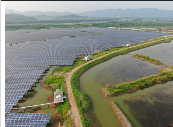
位置：检修道路 现场：检修道路两侧土路肩及填筑边坡实施植被恢复措施，路面采用碎石路面
