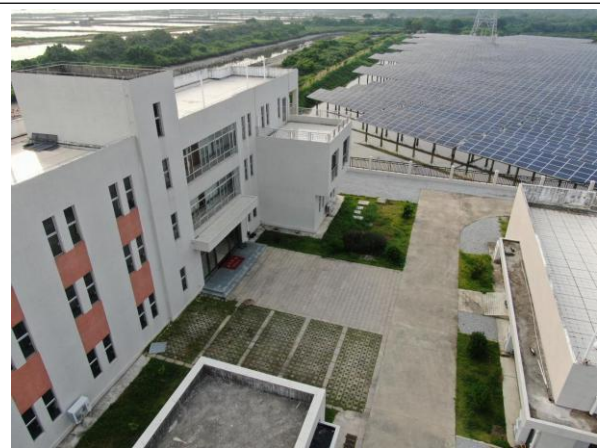
位置：升压站 现场：升压站站内外绿化区域实施植草防护，防护效果较好
