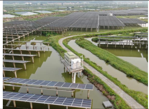
位置：检修道路 现场：检修道路两侧土路肩及填筑边坡实施植被恢复措施，路面采用碎石路面
