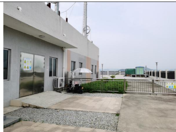
位置：升压站 现场：升压站站外绿化区域实施植草防护，防护效果较好
