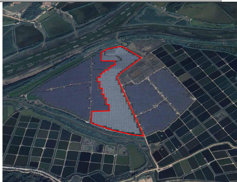
位置：西区光伏区 照片时间：建设后，2019年10月
