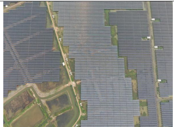
位置：光伏阵区 现场：光伏组件施工完成后，下部蓄水恢复渔业养殖，低压交流电缆通过桥架输送到箱变
