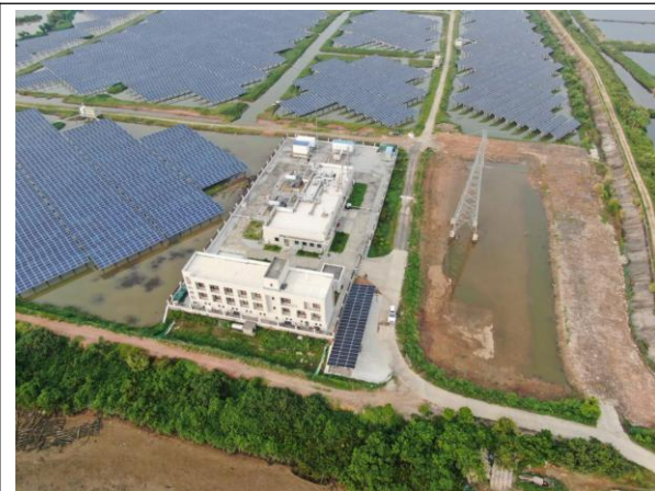
位置：升压站 现场：升压站内建构物区域均已完成硬化，站内外绿化区域进行落实植草防护措施
