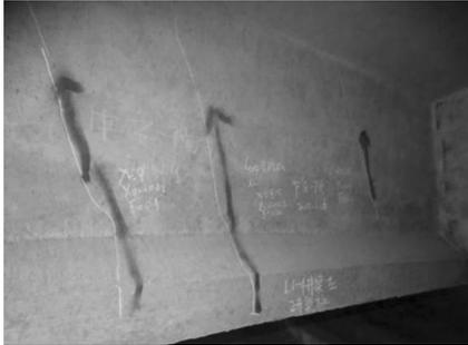
裂缝仅出现在1#、2#跨,3#跨未出现裂缝。检测报告对该桥前两跨上部结构评定为3类部件。
