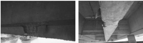
图 8 破损 5#梁现场照片 1-2
