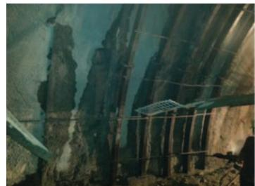
图4 设立临时加固钢拱架
