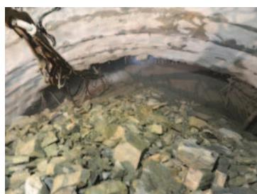
图3 C20混凝土对塌腔进行封闭
