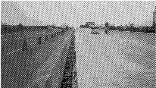
图6 桥梁拼接加宽
