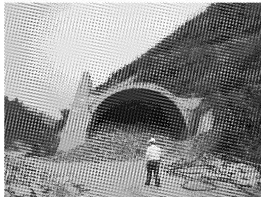
图2 斜交进洞(石排口梧州端洞口)
