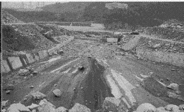
图11 沟口地段排导槽
