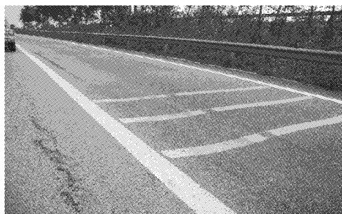
图7 江睦路立交匝道与主线相接处为下坡段、重车多,有坑槽、推移、车辙病害
