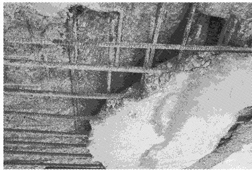
图 4 防崩箍筋较少处混凝土脱落
